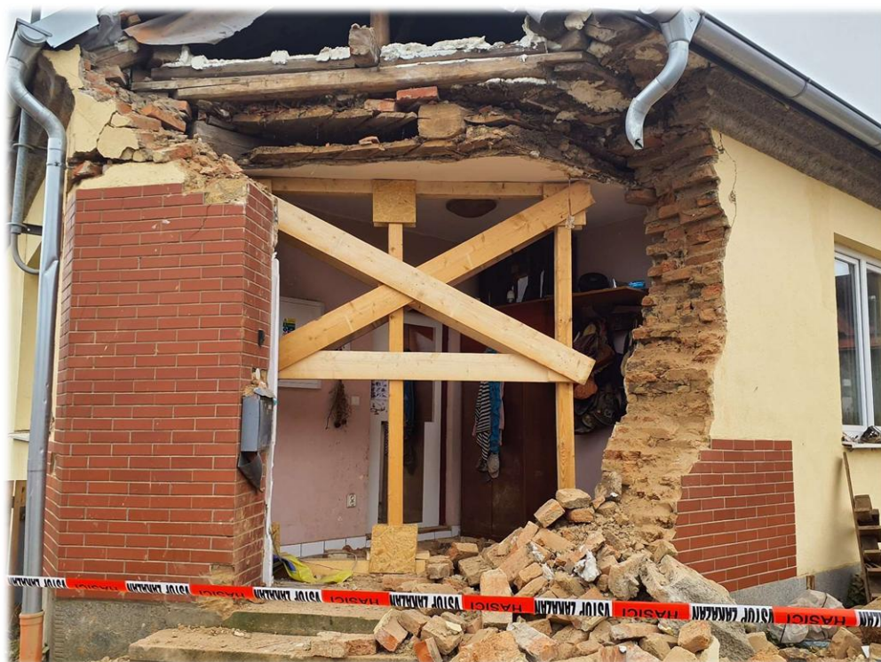
Obrázek 12: Stabilizace objektu po DN.
