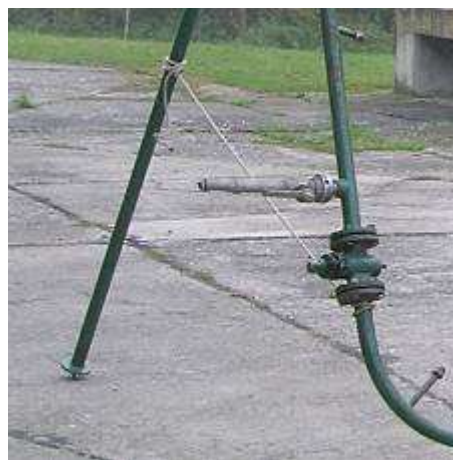
Obr. 52 Detail záslepky s využitím proudnice
