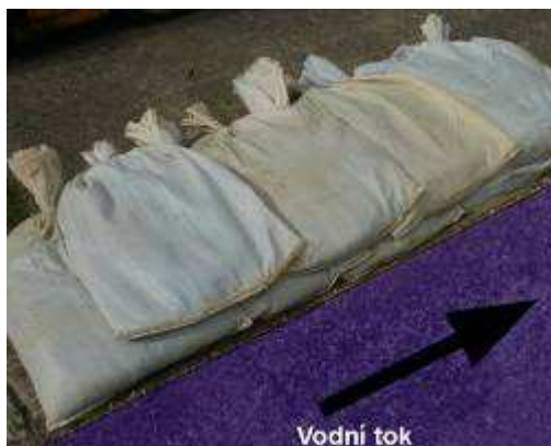
Obr. 5 Způsob kladení jednokomorových pytlů
