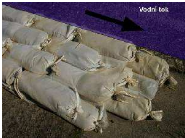
Obr. 15 Způsob kladení dvoukomorových pytlů
