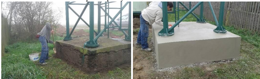
Oprava patky stožáru Řehořov:
