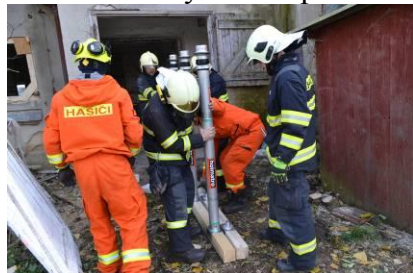
Výcvik na pažení stěn, Havlíčkův Brod, m.č. Šmolovy, 26. - 27.10.2015.
