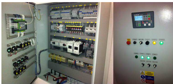
Instalace rozvaděče na stanici Polná:
