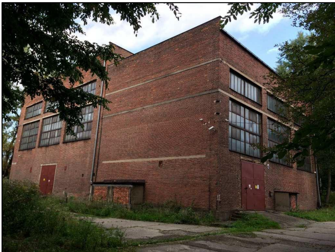
Obr. 8 Pohled na předmětný objekt (rok 2018)
