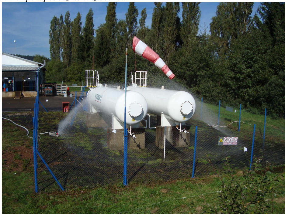
Obrázek č.7: Zkrápění poškozeného zásobníku
