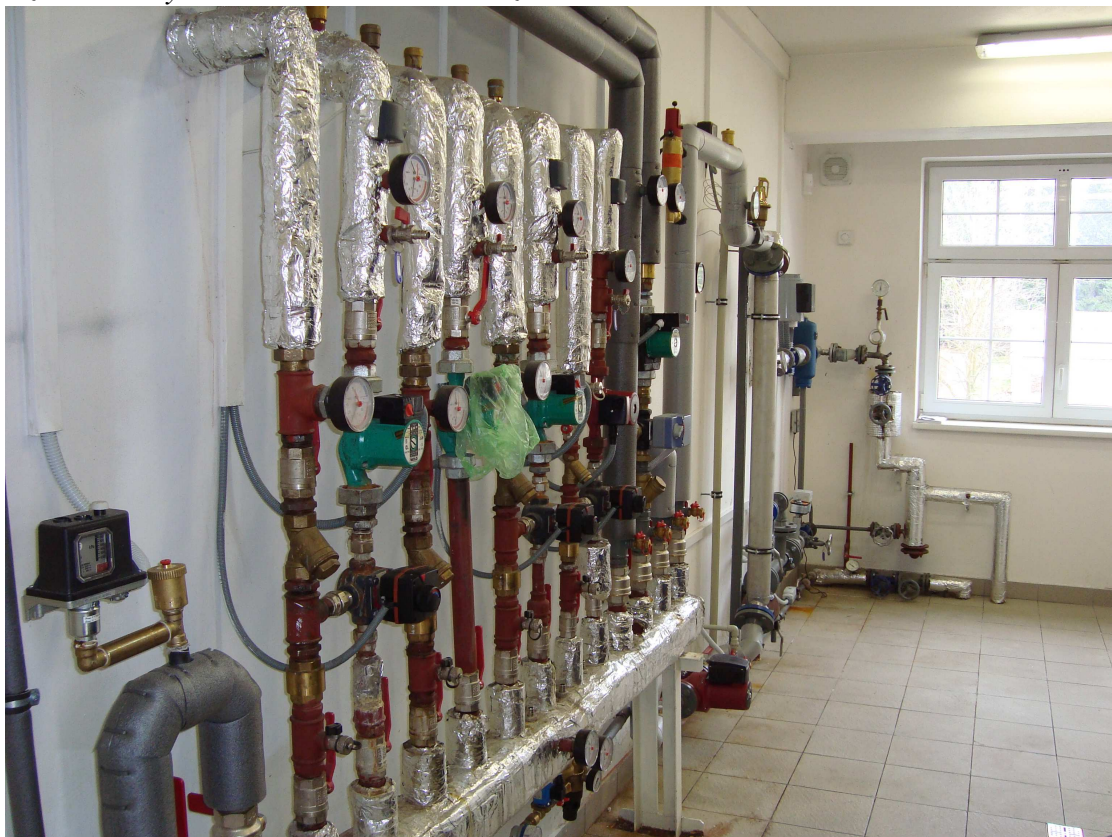
Obrázek č.25: Výměníková stanice v M. Lázních
