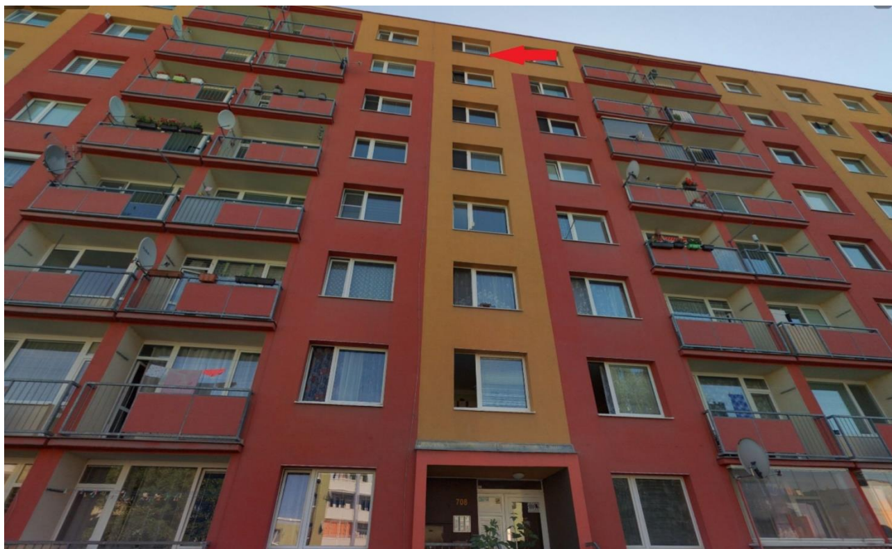
Pohled na objekt s místem požáru
