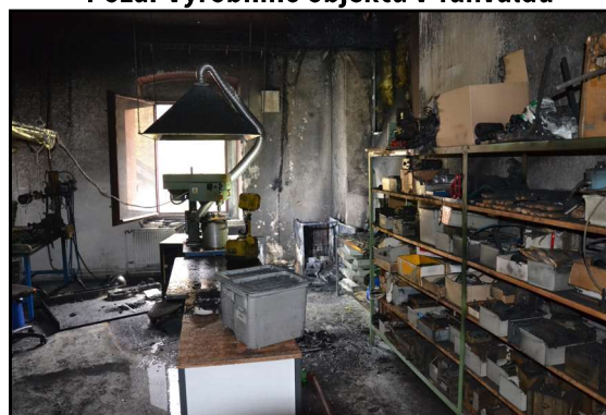
Požár výrobního objektu v Tanvaldu
