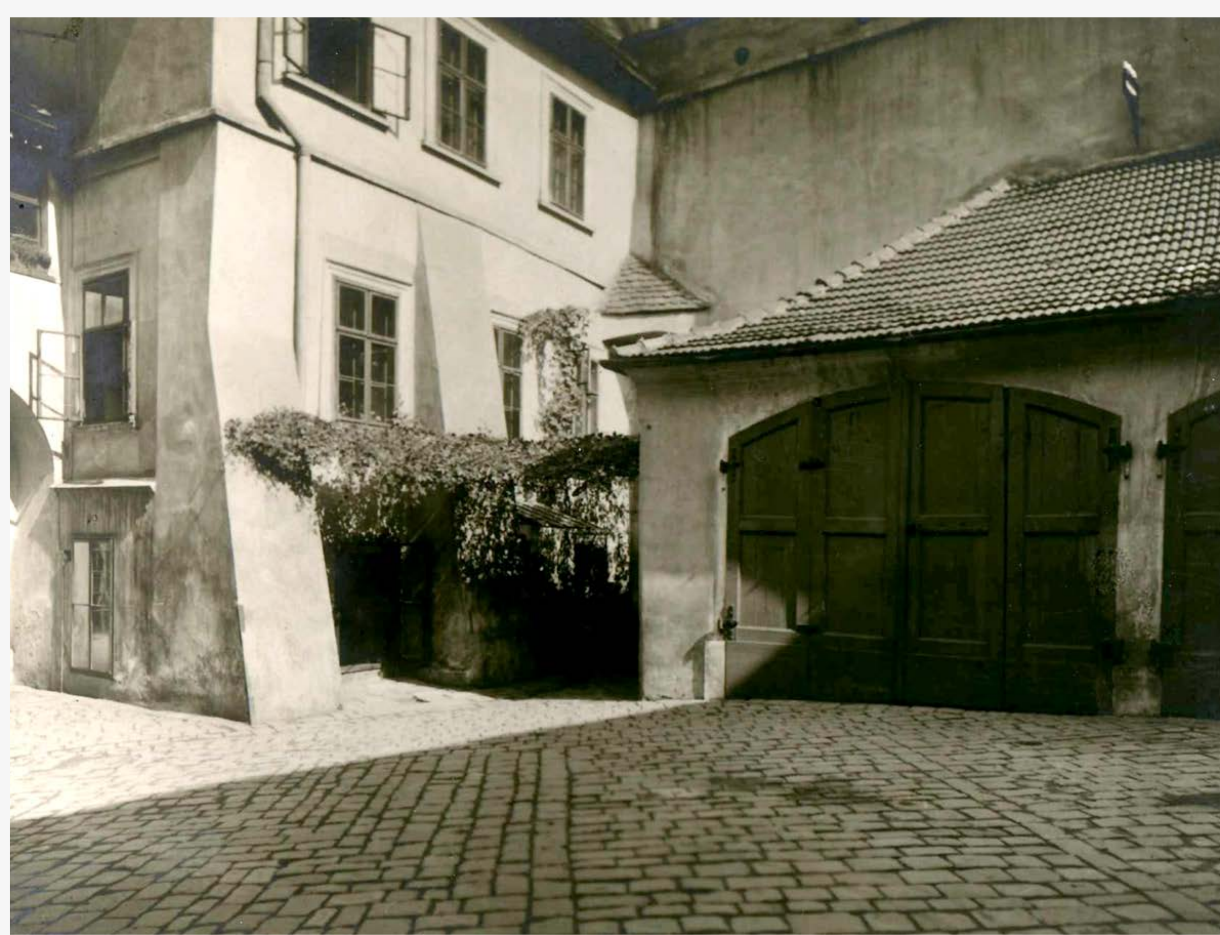
Nádvoří radnice. Vlevo v suterénu byla požární telefonní ústředna.
