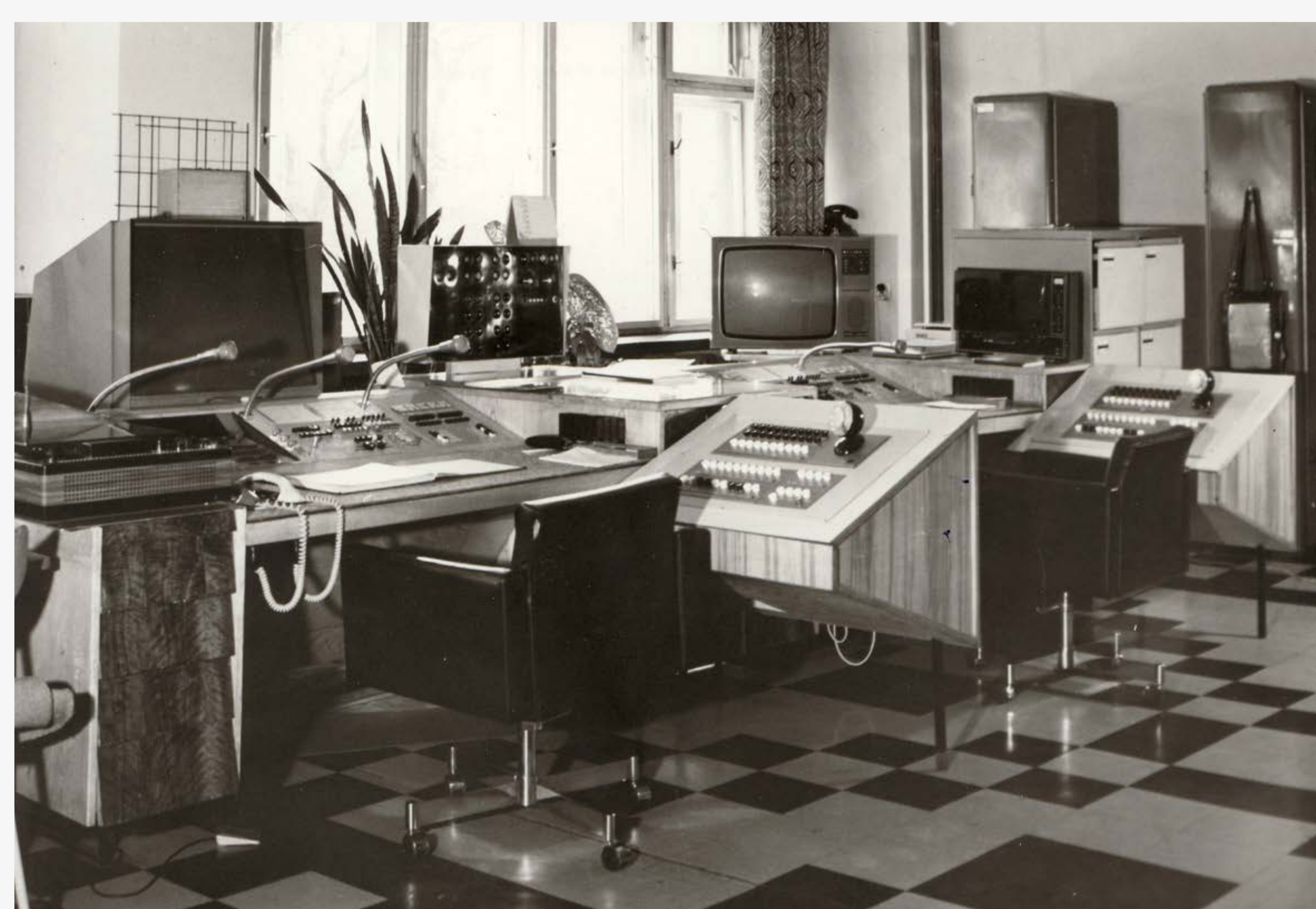
Spojovací sál požární ústředny v 80. letech
