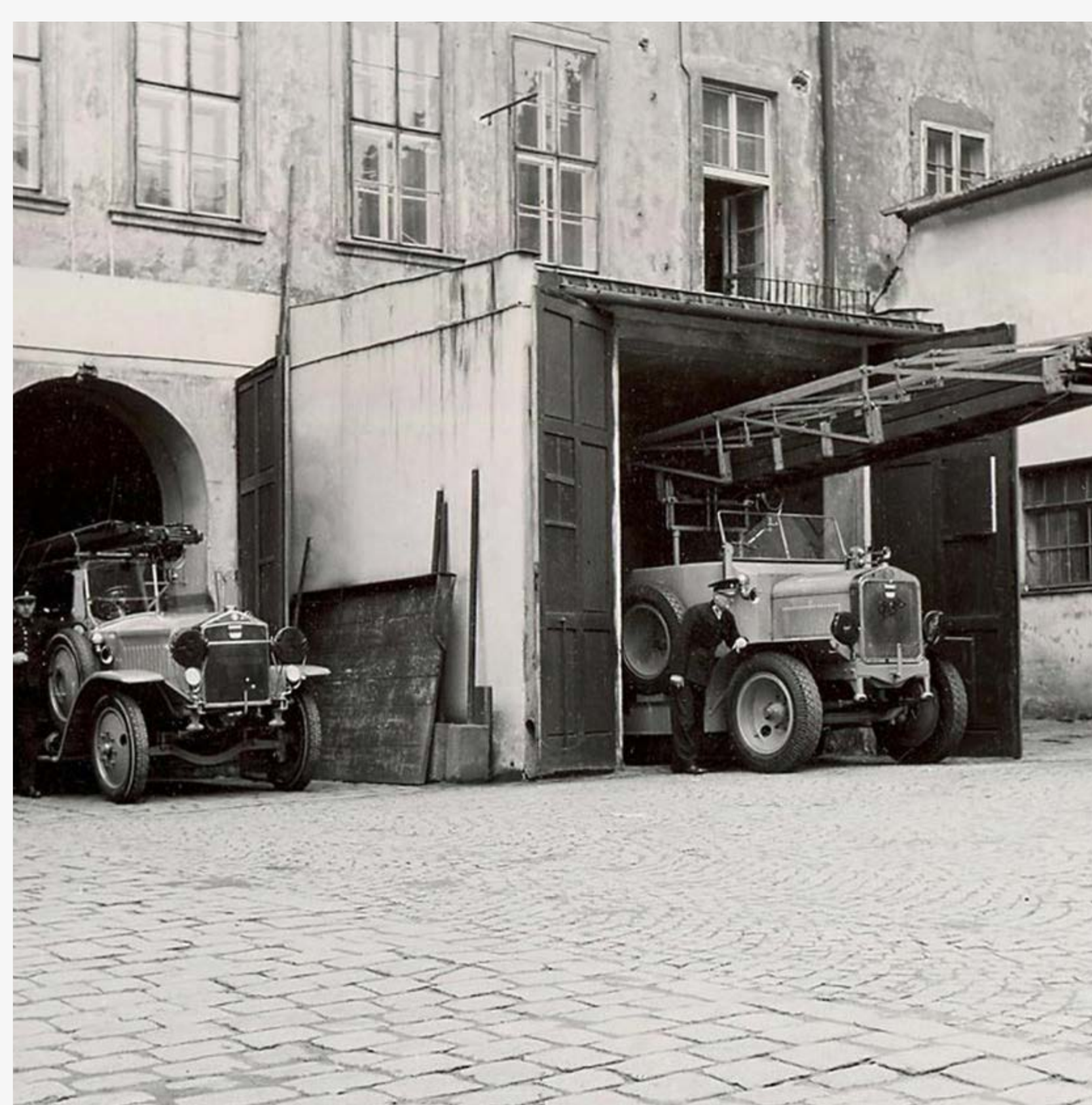
Garáže ve dvorním traktu Staré radnice
