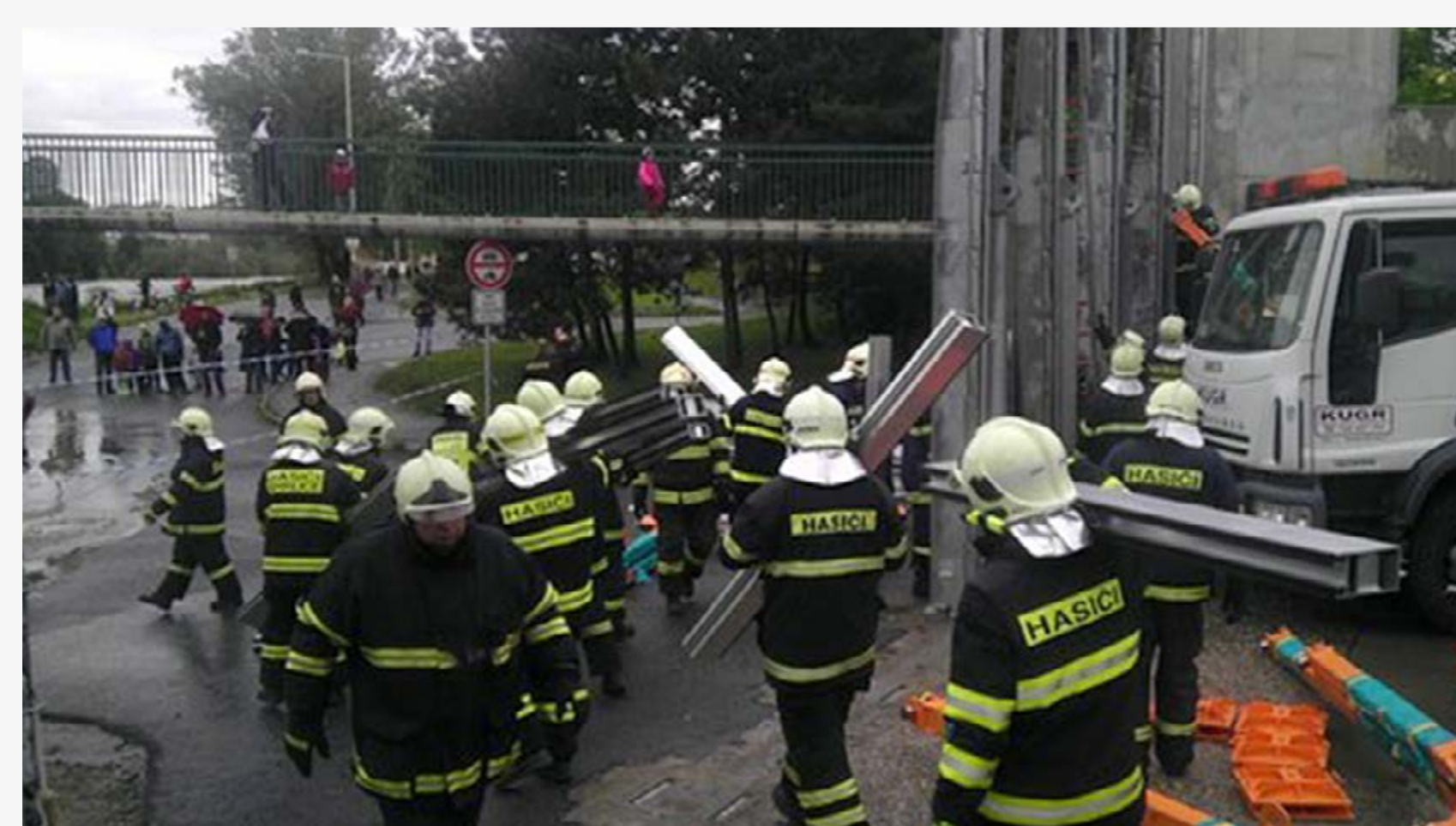
Stavba protipovodňových hrází
