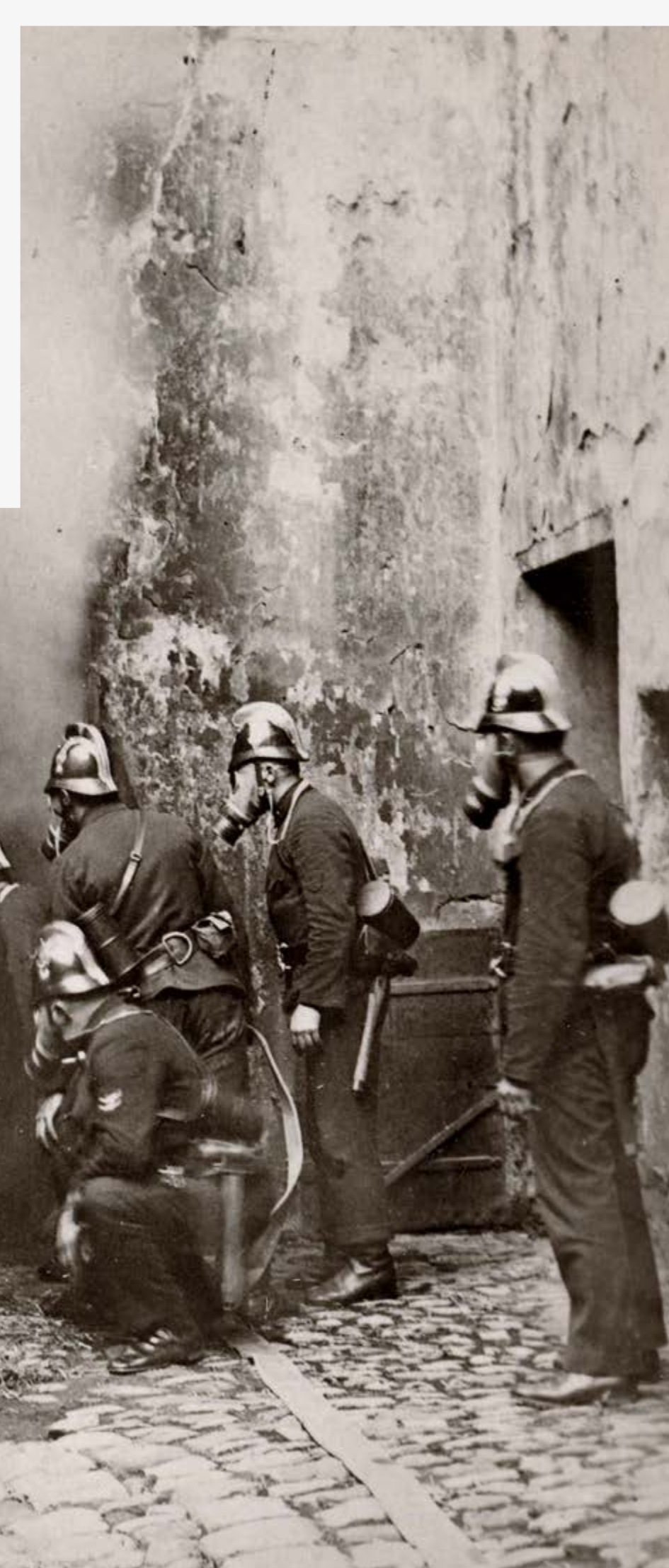
Výcvik zásahu při sklepevém požáru
