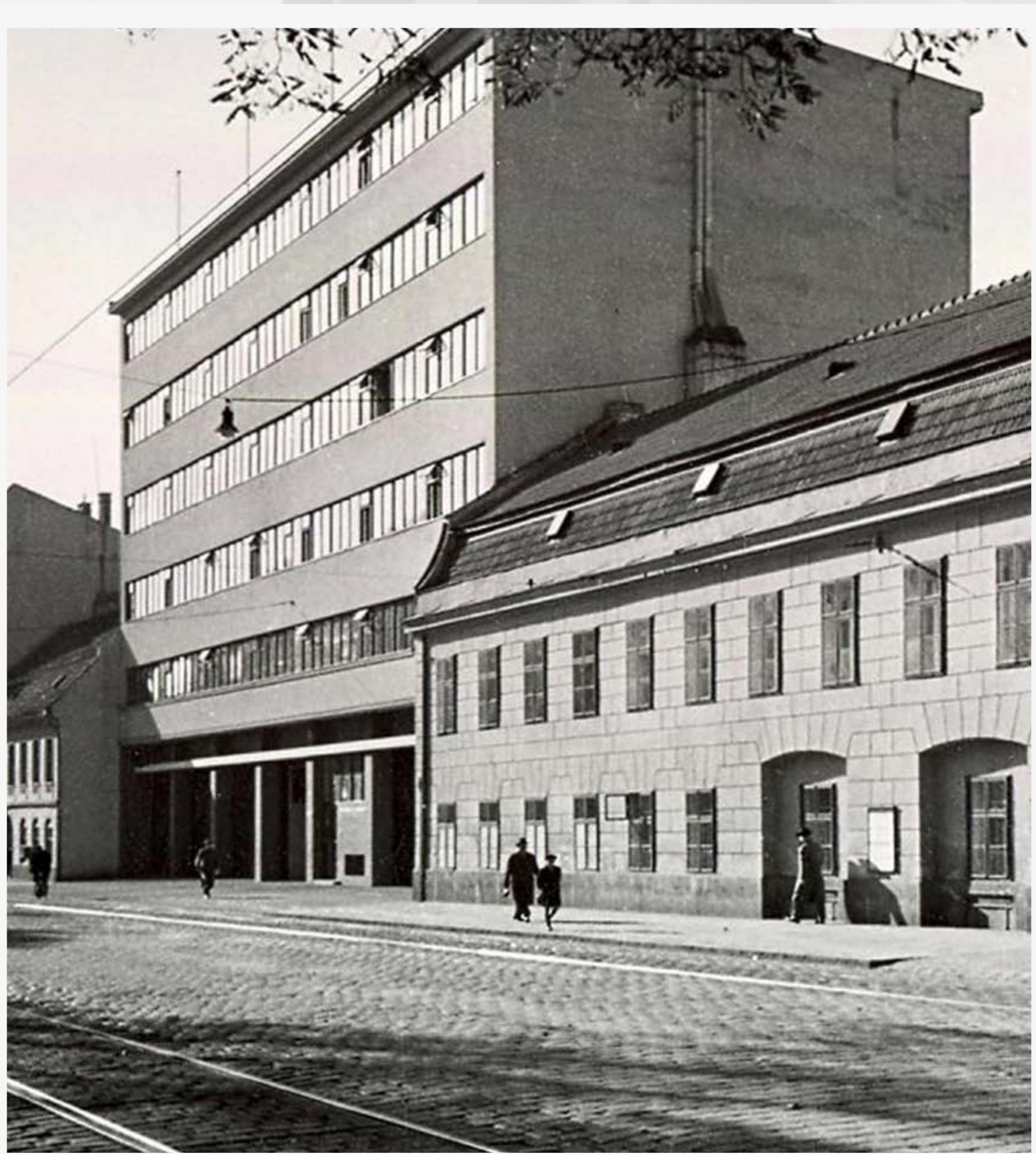
Uliční fronta nové stanice s výjezdy z garáží
