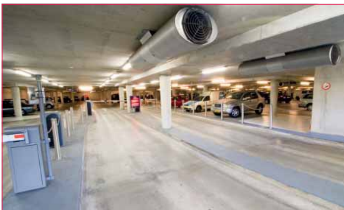
Obr. 4 Ukázka instalace proudových a odsávacích ventilátorů [7]
