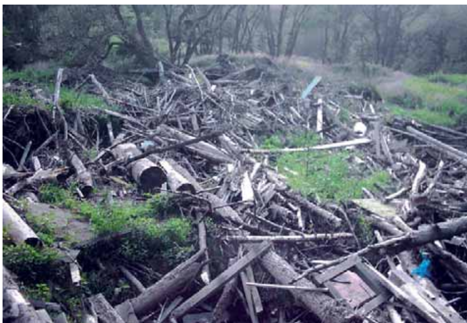
Splaveniny a zátarasy - pohled na vtoku do nádrže VD Husinec
