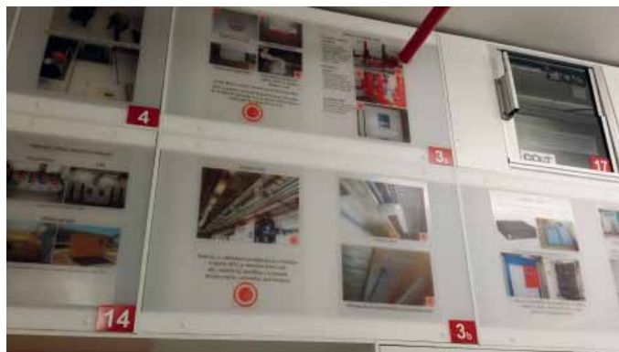
Vodní stabilní hasicí zařízení, které je na fotografiích a jehož aktivace je vyjádřena podsvícením
