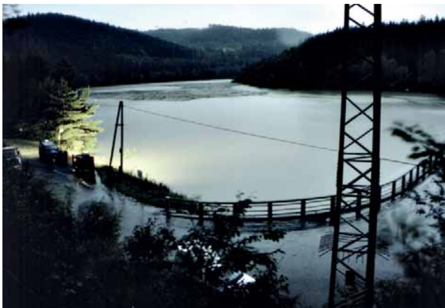
VD Husinec - celkový pohled na připlouvající splaveniny
