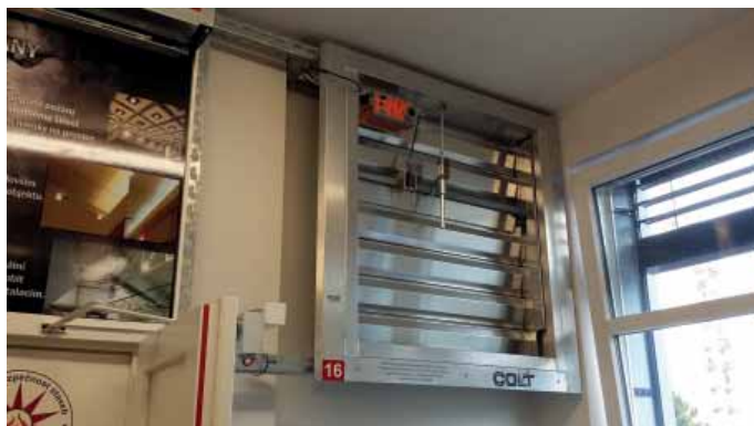
Dveře s přídržným magnetem, kouřová zástěna, klapka zařízení pro odvod kouře a tepla
