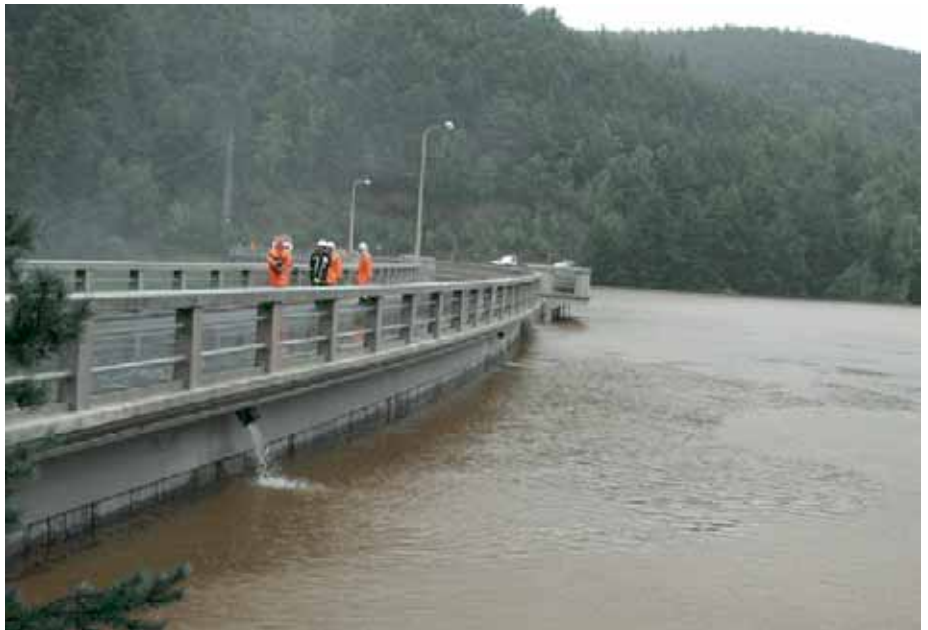
Kulminace povodně - pohled na návodní líc VD Husinec
