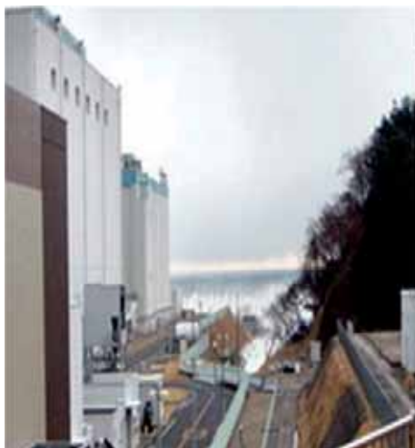
Jaderná elektrárna Fukušima před a po tsunamí: a) tsunamí se blíží k jaderné elektrárně
