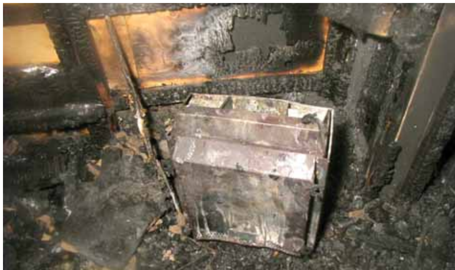
Saunová kamna v ohnisku vzniku požáru
