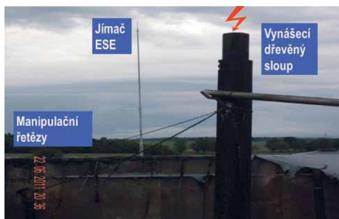
Obr. 3 Poškozená technologická část fermentoru po úderu blesku do ochranného prostoru jímáče ESE
