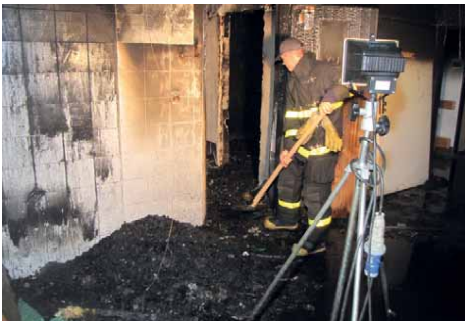
Ohledání místa požáru
