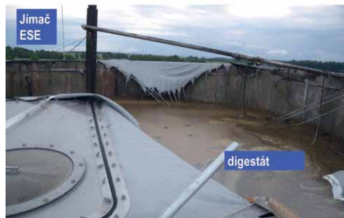
Obr. 6 Pohled do poškozené vnitřní jímky fermentoru, která se celá nachází v ochranném prostoru jímáče ESE
