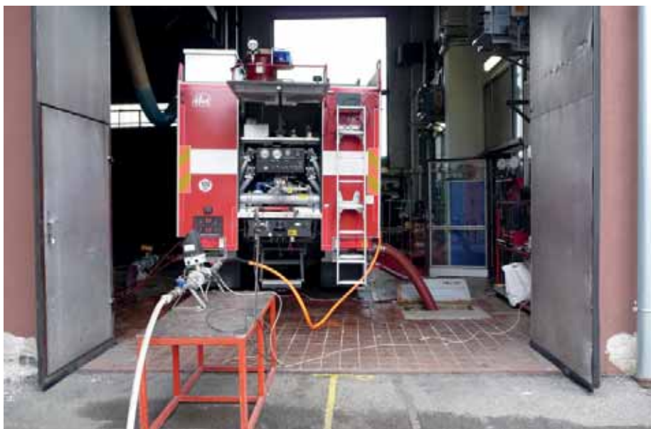
Zkouška průtoku vysokotlakého zdroje
