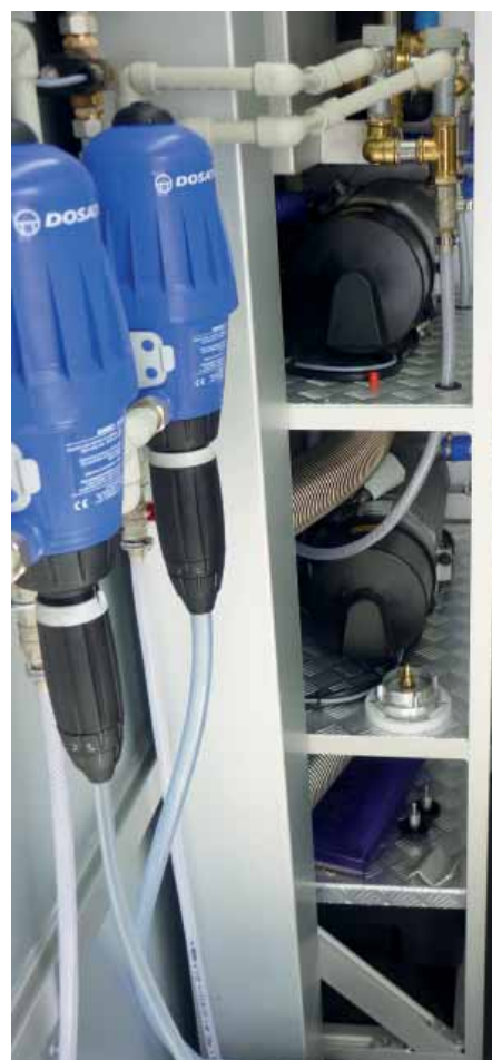
Technologická část – ohřev vody s příměšovači
