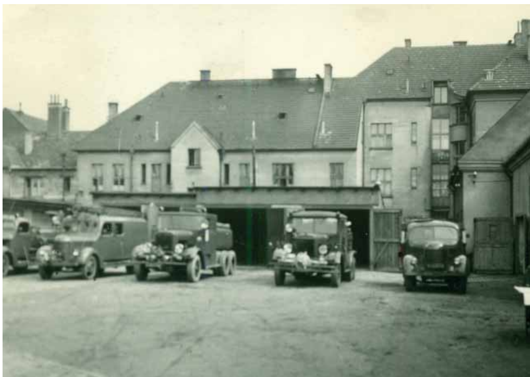
Požární technika na dvoře kladenské stanice v padesátých letech
