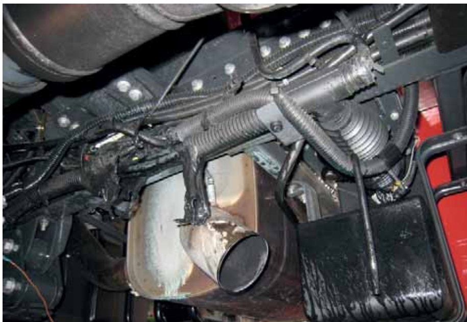
Propálená kabeláž u výfukového potrubí
