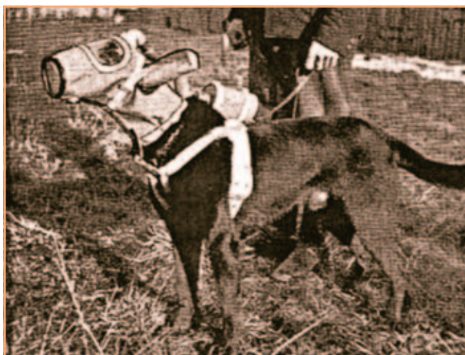
Kompletní speciální maska pro koně a psy se dvěma filtry „CHEMA BS“ propojenými vřapovou hadicí po stranách
