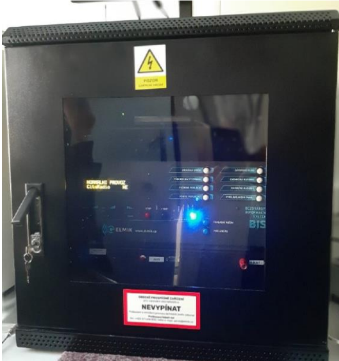
Skříň řídicí elektroniky ústředny MIS – uzavřená
