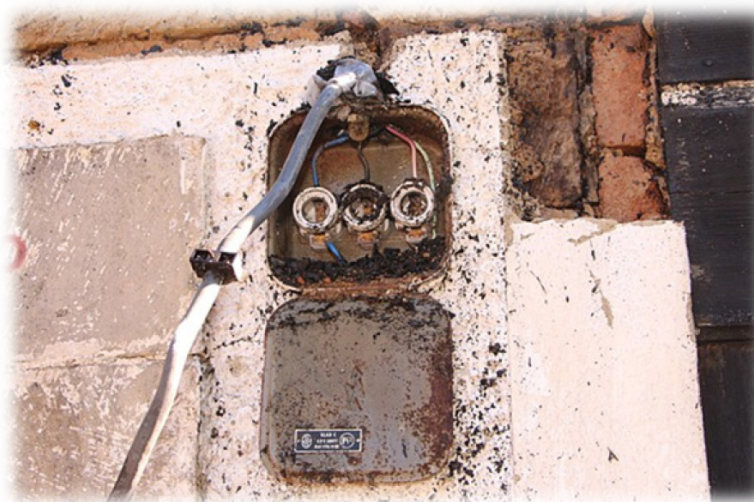
Obrázek 22 - el. pojistková skříňka vpravo nad vstupními dveřmi, na jižní straně domu, směřující k silnici....bez pojistek
