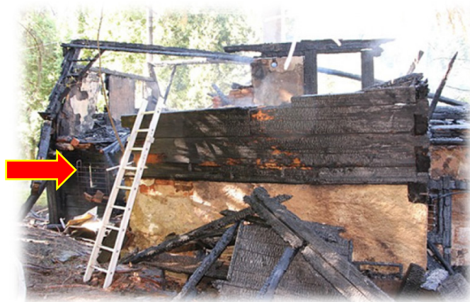
Obrázek 6 - celkový pohled na severní stranu domu...šipka označuje místo, kde byl pořízen snímek č. 7
