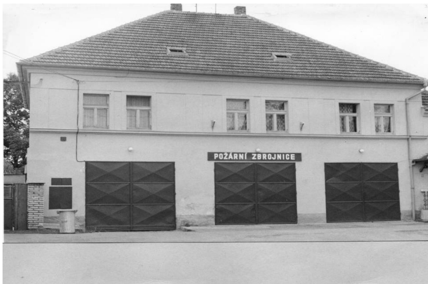
bývalá budova JSDHO Přeštice
