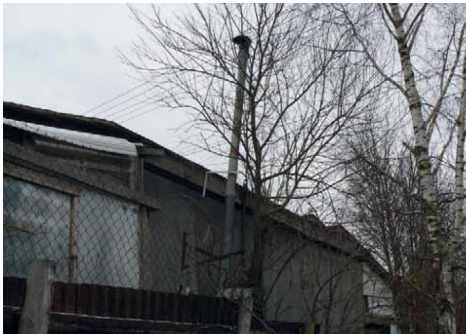
Komín z okapových svodů
