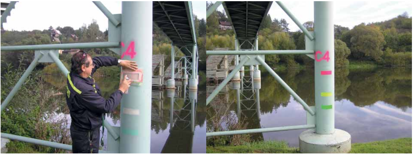
Hlásný profil Stradonice – stav před a po obnově značení v září 2012
