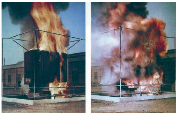
Fáze hašení požáru sprejovým hasičím zařízením
