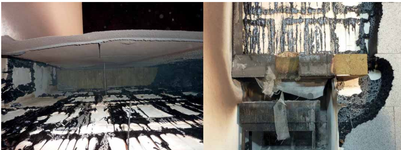
Obrázek 1 Vzorek po zkoušce podle [3] - Po odstranění krycích vrstev je patrna absence tepelného izolantu mezi požárními bariérami s výškovou roztečí 3 m
