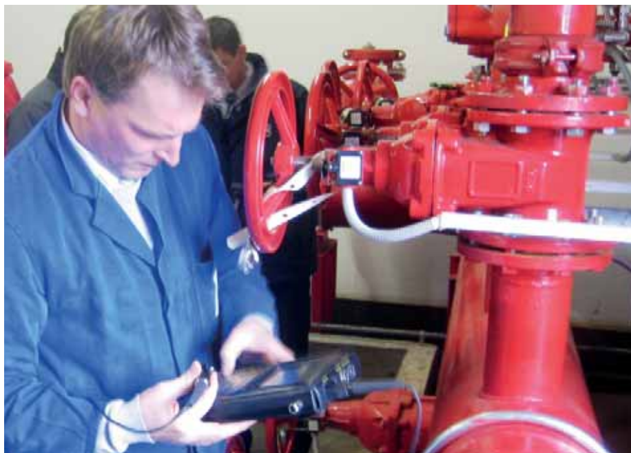
Kontrola sprinklerového potrubí inspektorem VdS
