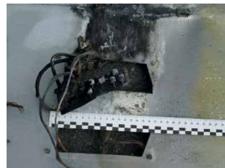
Zajištěné zbytky podkladu a A-boxu
