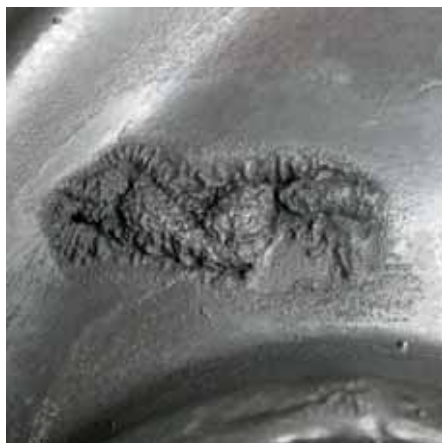
Obr. 2 Vypálený otvor ve dnu po vyčištění brusným ocelovým kartáčem
