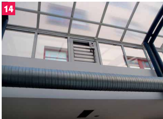
Výměna plynů při vnitřním požáru, neutrální rovina, nucené podtlakové větrání stropní kouřové zástěny kouřové sekce
