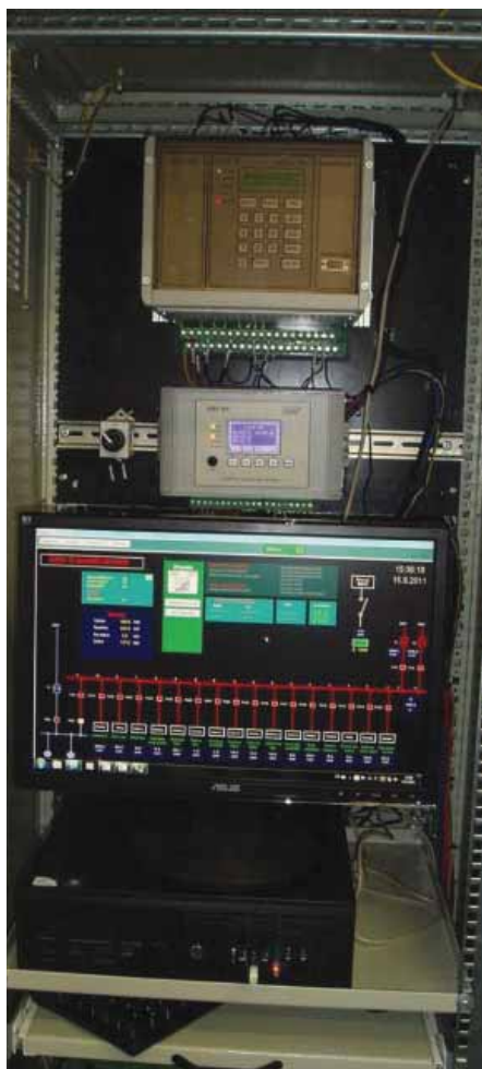
Pohled na automatiku řízení ostrovního provozu v českobudějovické čistírně odpadních vod
