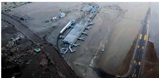
Obr. 5: Škody na infrastruktuře při zemětřesení a tsunami 11.3.2011 – letiště v Sendai [7]
