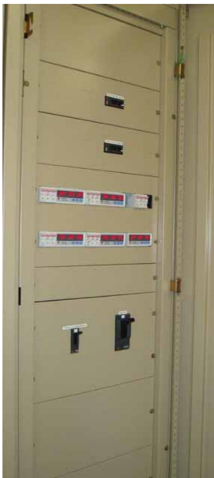
Pohled na automatiku řízení ostrovního provozu v českobudějovické čistírně odpadních vod
