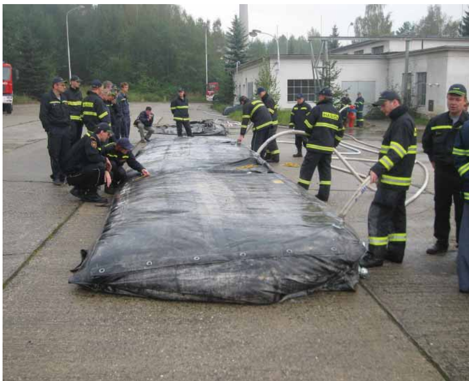
Pracoviště stavění protipovodňové hráze z jednokomorových vaků
