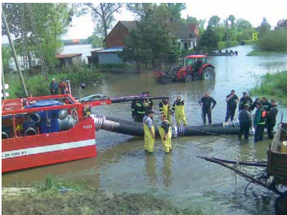
Instalace MČS 20 - 1500 k zásahu
