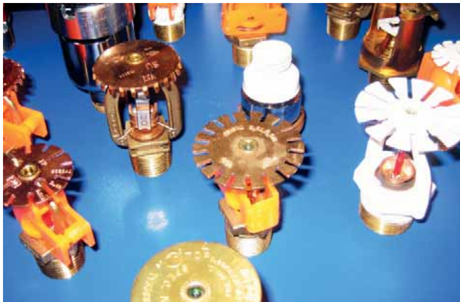
Typické sprinklery moderní konstrukce
