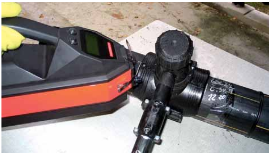
Vyhledání místa porušení potrubí
